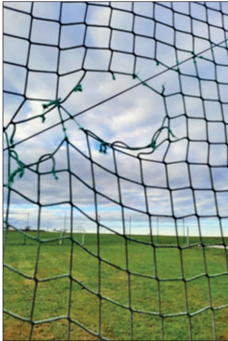
Defektes Ballfangnetz in Tanneberg
