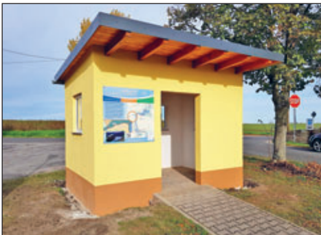
Die neue Bushaltestelle „Pension Hammer“ in Tanneberg
