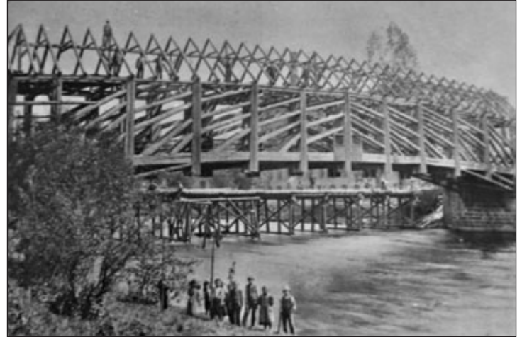
Die 1813/14 erbaute Holzbrücke in Neudörfchen vor dem Abriss im Jahr 1895
