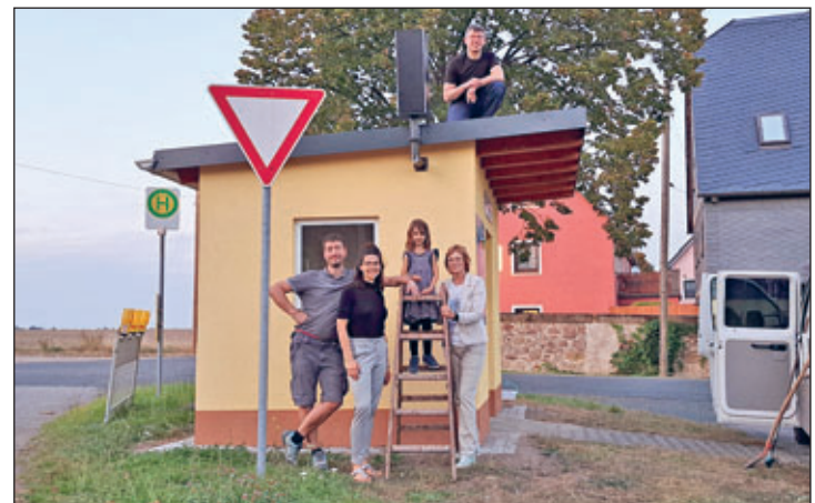
Arbeiten an der Bushaltestelle in Tanneberg
