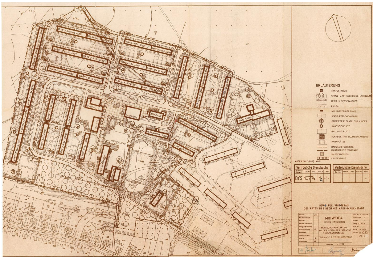
Quelle: Stadtverwaltung Mittweida, 2. Bauphase in Plattenbauweise (zumeist IW 72) und zentralem Versorgungsbereich
