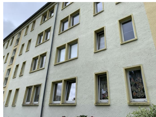
unsanierter Wohnblock Lauenhainer Straße 19-25
