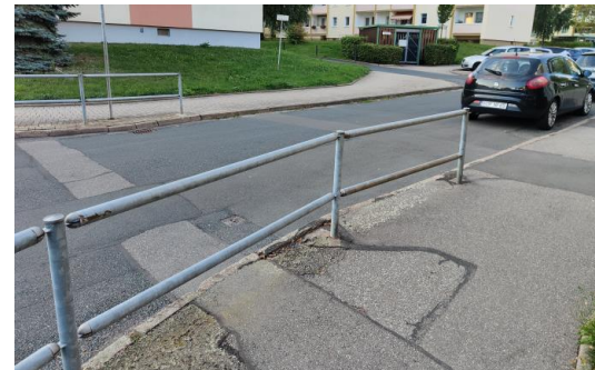
nicht barrierefreie Fußwege Lauenhainer Straße
