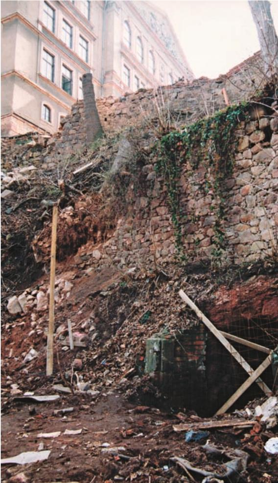
Der desolante Bauzustand der Geländestützmauer, 1993
