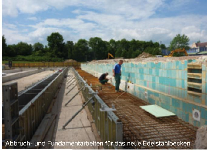
Abbruch- und Fundamentarbeiten für das neue Edelstahlbecken
