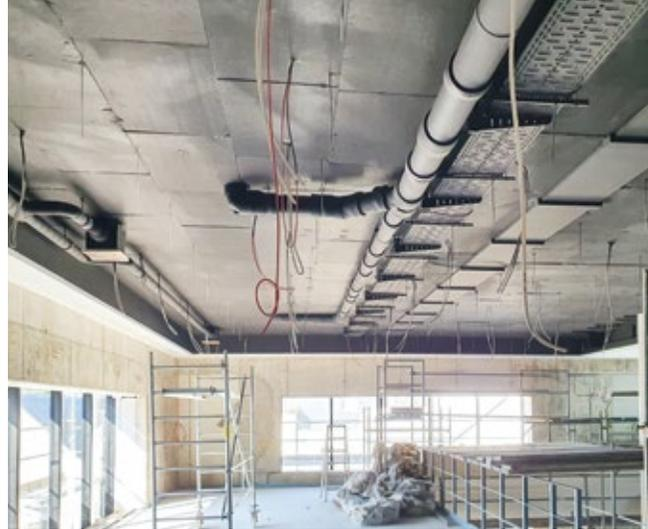
Einbau Elektro, Lüftung und Entwässerung (September 2022)
