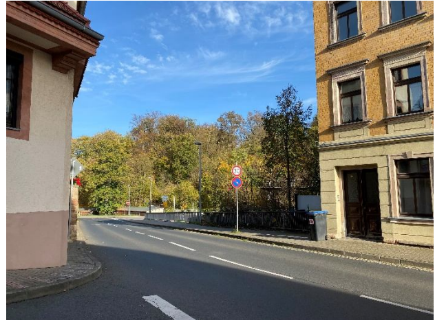
unübersichtliche Gefahrenstelle für Fußgänger an der Einmündung des Auensteigs in die Waldheimer Straße mit Übergang zum Z. Busbahnhof
