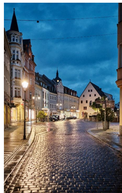
bereits umgerüstete Straßenbeleuchtung in der Altstadt (Fortführung für das Neubaugebiet geplant)
