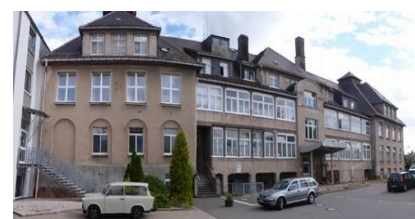
Blick auf die Brache Albertstift. Der Gebäudeteil steht seit Anfang der 1990er Jahre leer.
