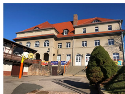
Gegenwärtige Bestandssituation und Erscheinungsbild der öffentlichen Einrichtung von der Straße aus
