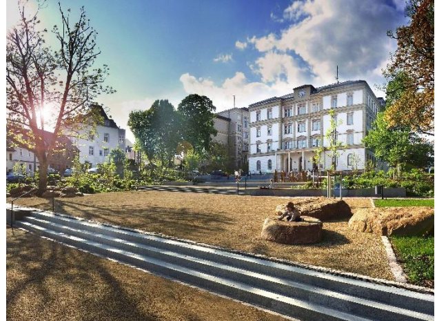
Blick über den Technikumplatz zum Hochschulgebäude
