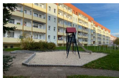
Blick auf die bestehenden Spielplatzanlagen und Kommunikationsbereiche im Neubaugebiet.
